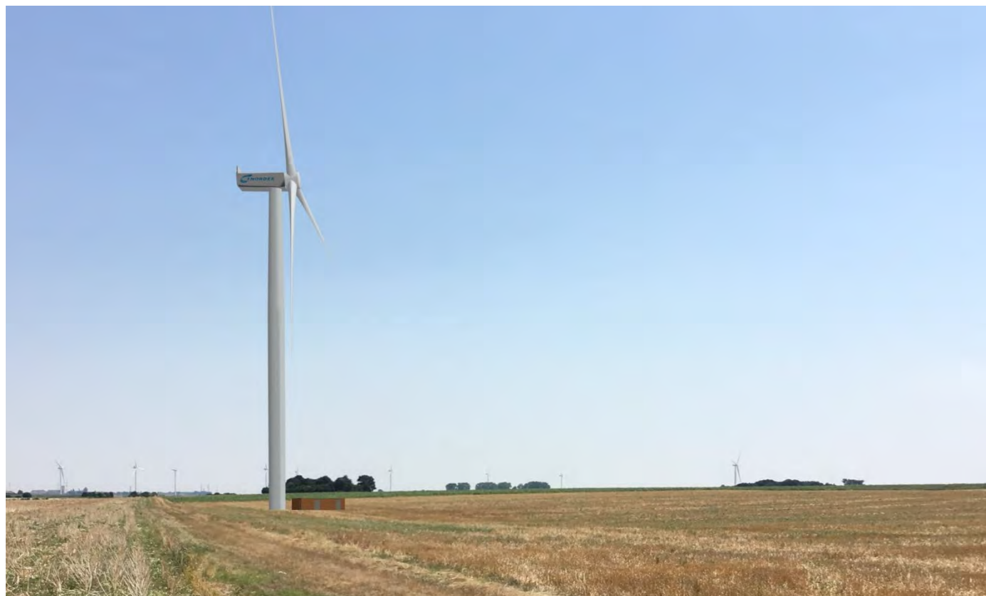
FIGURE 24 -INSERTION PAYSAGERE DU POSTE ELECTRIQUE AU PIED DE L'EOLIENNE N°6 DEPUIS LE CHEMIN D'EXPLOITATION DEPUIS NICORBIN VERS LE BOIS DE LA FOLIE.
