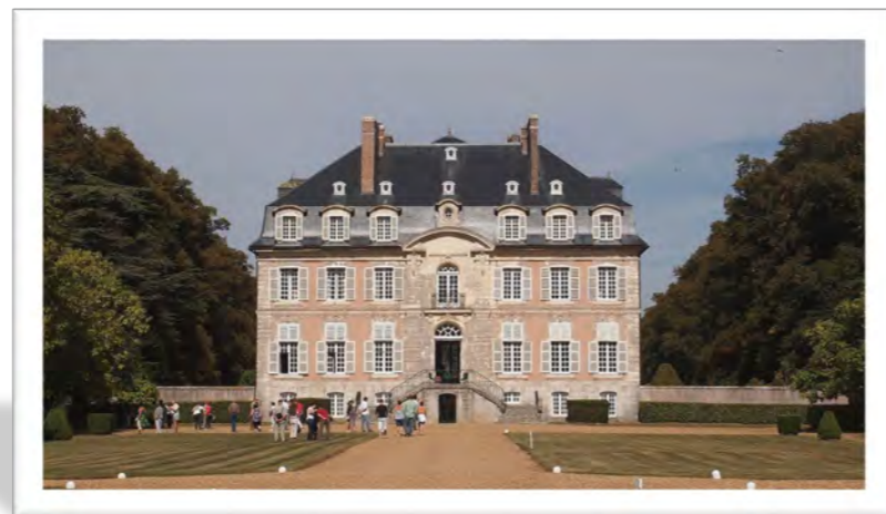
PHOTO 18 - CHATEAU DE REVERSEAUX – FAÇADE SUD
